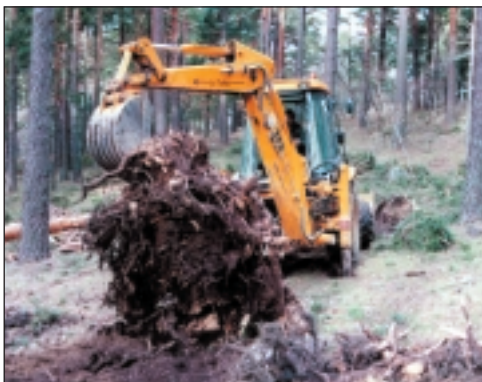
Extracción del tocón y raíces gruesas.
